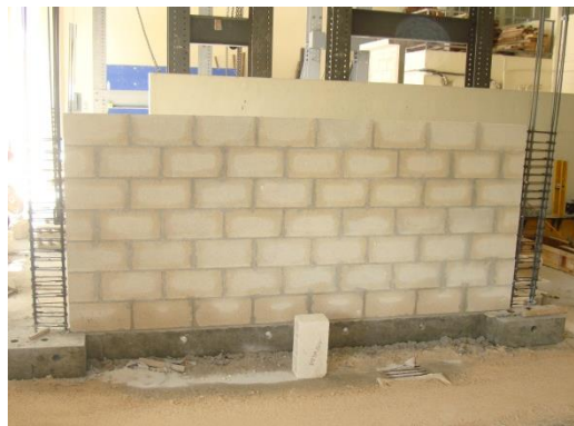
Figura 3.29 Colocación de bloques huecos de concreto
