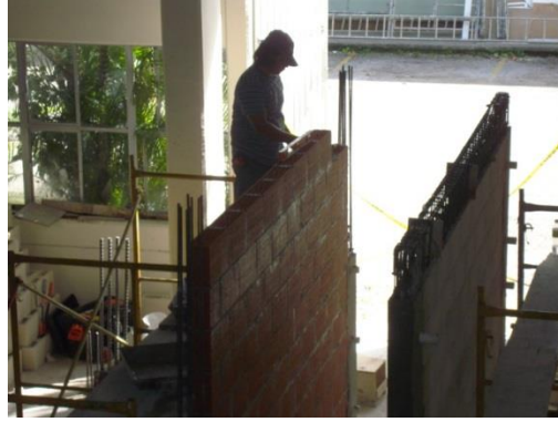
Figura 3.30 Colocación de tabiques de arcilla extruida
