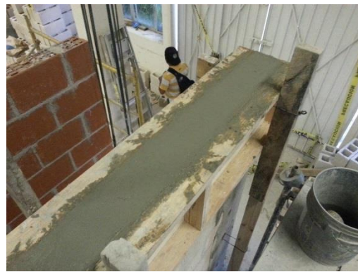
Figura 3.31 Colado de cadena superior
