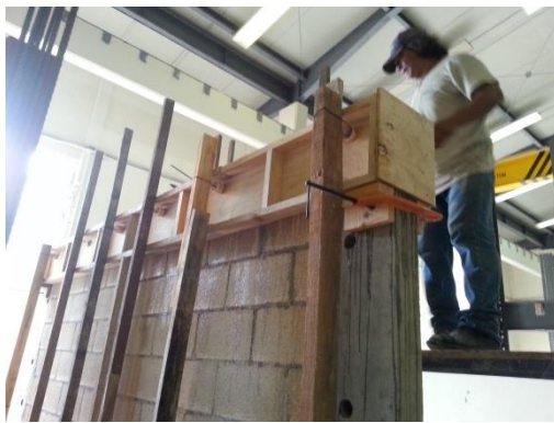
Figura 3.31 Colado de cadena superior
