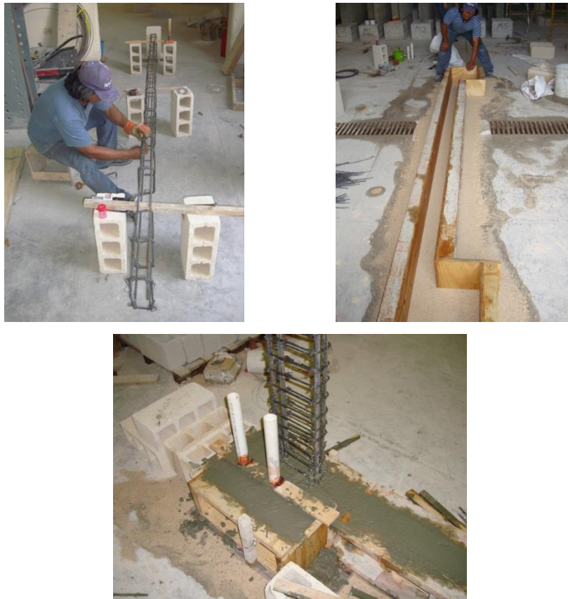
Figura 3.28 Habilitado del acero de refuerzo y colado de cadena inferior
